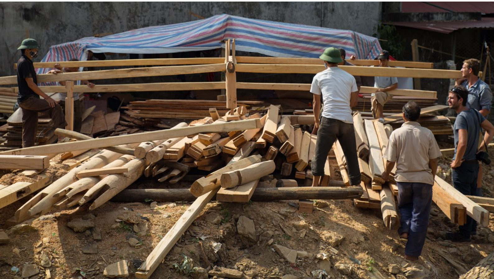
Antoine et Tristan sur le montage de la charpente d'une maison, MeoVac, Vietnam
